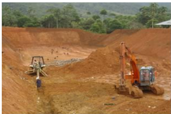
Excavación de cunetas para filtros
