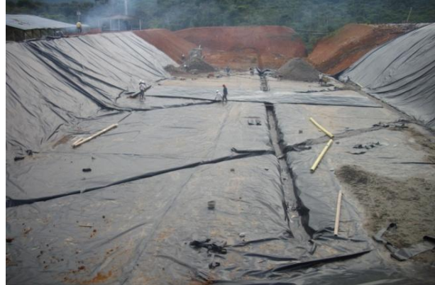
Vaso 3. Se observa al fondo la conformación de las primeras celdas diarias
