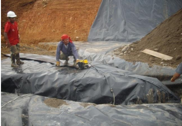
Protección de Geomembrana con arena
