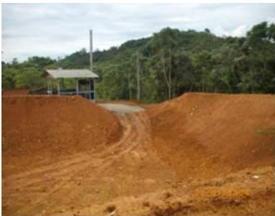
Vía de acceso al tercer vaso 3.
