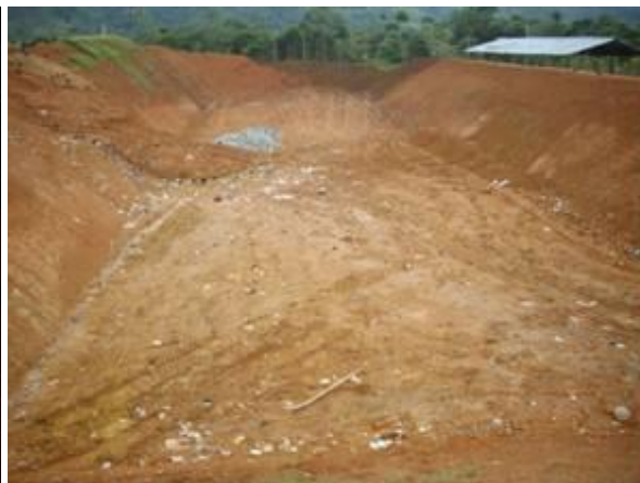
Excavación completa del vaso 3.
