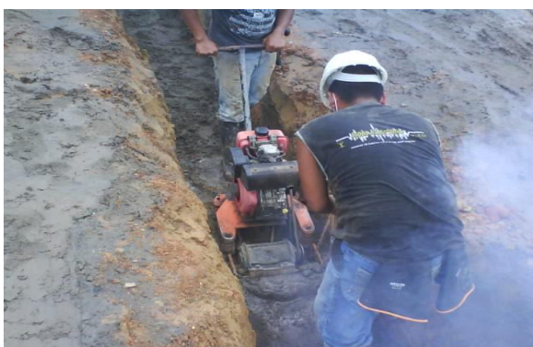
Adecuación y compactación de arena para soporte y protección de Geomembrana
